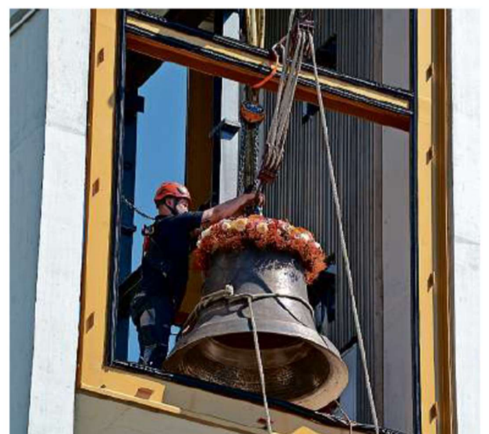
Vollbracht: Die neue Glocke ist im Turm.
